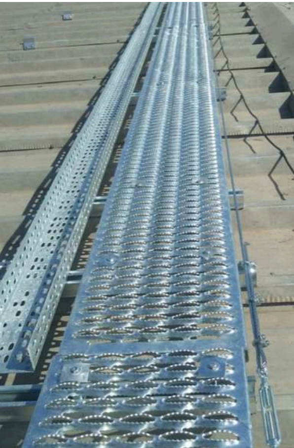
SOLUCIÓN DE PASILLO TÉCNICO CON CABLE DE VIDA
