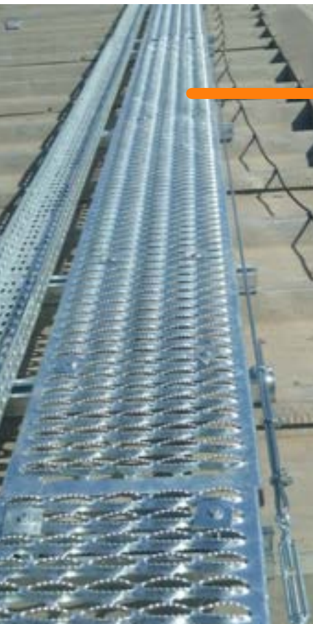
SOLUCIÓN DE PASILLO TÉCNICO CON CABLE DE VIDA
